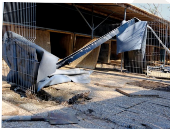
▲ Der Umbau ist bereits in vollem Gange.
